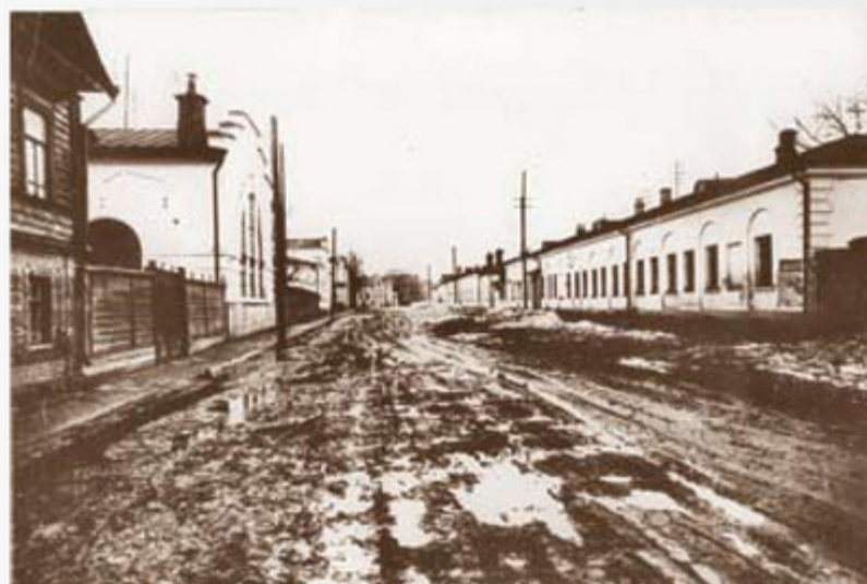
Электростанция и радиотехническая мастерская (Ратемас) НРЛ на ул. Жуковской (ныне ул. Минина)
