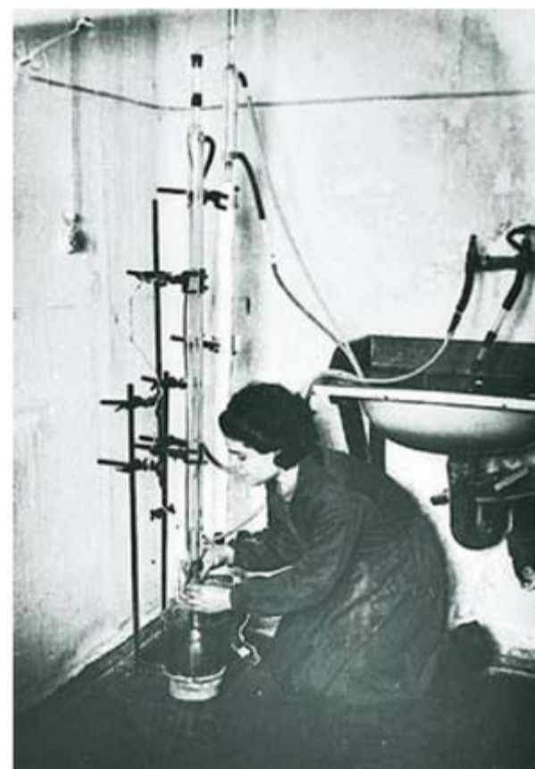
Лабораторная установка по получению наркотического эфира на кафедре физической химии. С.З. Делиховская. 1942 год
